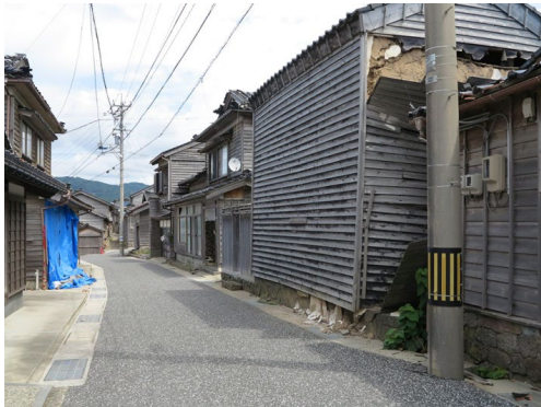
photo. 14 震災後の輪島市門前町「黒島の集落」
