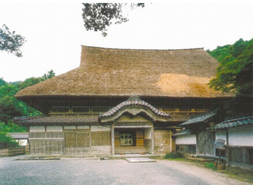
photo. 3 災被害前の上時国家住宅全景
