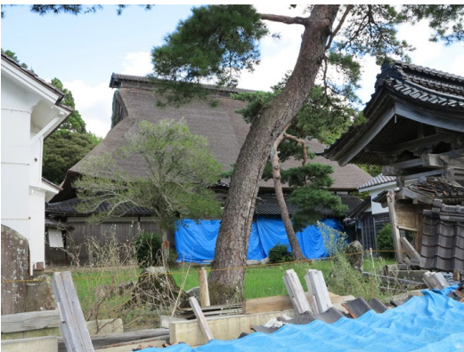
photo. 11 震災後の室木家住宅全景
