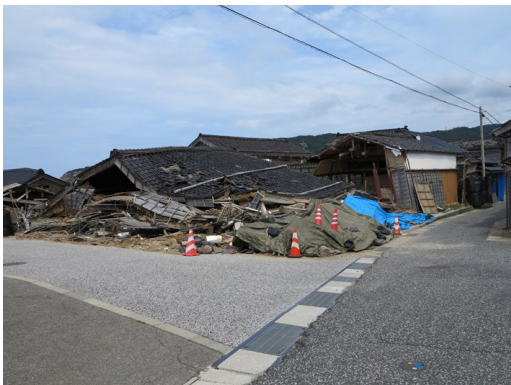
photo. 2 震災後、一部を残し倒壊した旧角海住宅
