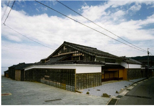
photo. 1 震災被害前の旧角海住宅全景
