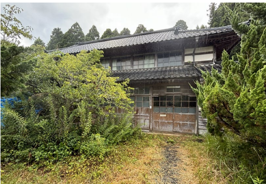
photo. 10 震災後の泊家住宅全景
