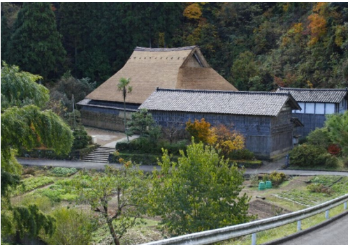
photo. 7 震災前の黒丸家住宅遠景
