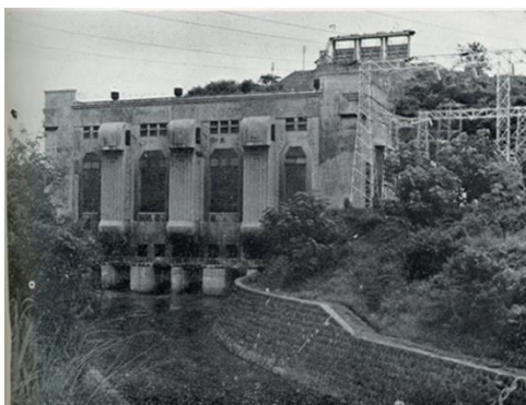
図9:猪苗代第三発電所
