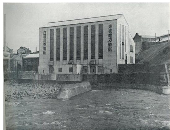
図5: 日橋川発電所 7
