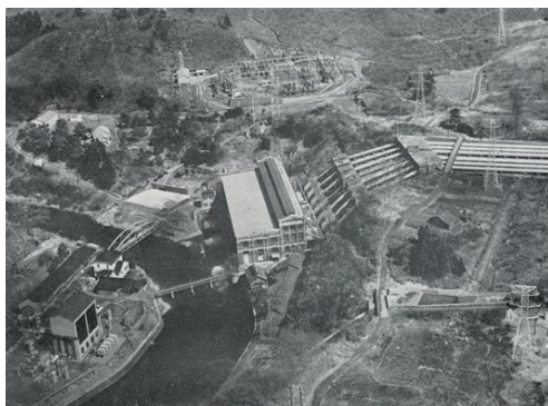
図6:猪苗代第一発電所
