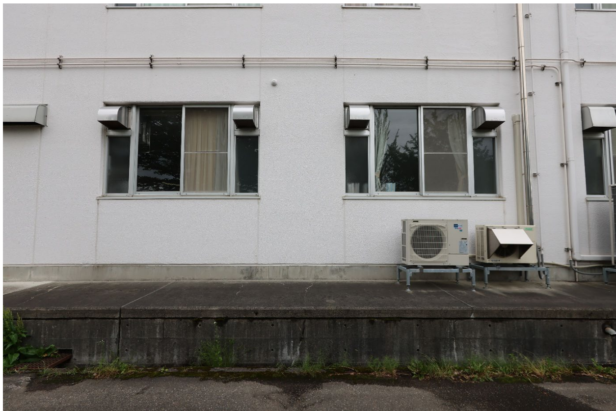
栄養実習室外壁に給湯器2台を設置。なお、外壁については下記写真のとおり。
