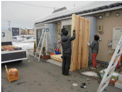
風よけ、雪よけ設置の様子
