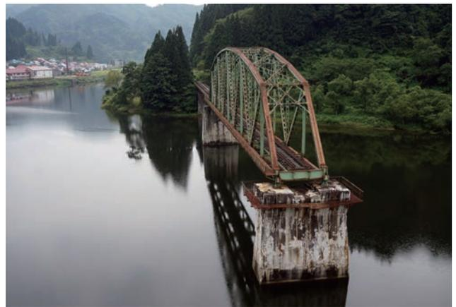
図11 2011年7月の新潟福島豪雨災害で破壊された第五只見川橋梁※2017年現在も復旧していない(2015年9月5日 金山町) 筆者撮影
