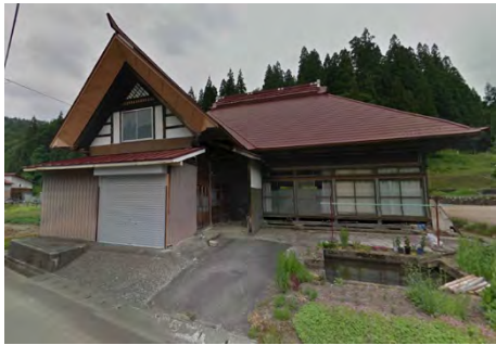
fig. 4 入母屋(主棟)+切妻形状屋根(突出部) 民家
