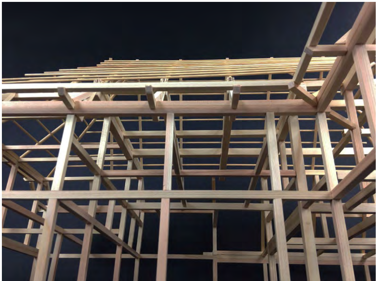
fig. 34 実測をもとに製作した軸組模型 軒先
