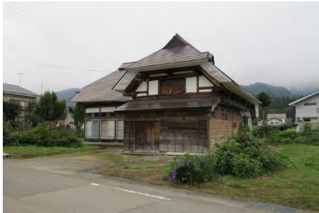
fig. 5 入母屋(主棟)+兜屋根形状(突出部) 民家
