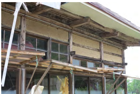
fig. 6 軒先を深くしている「せがい」部分
