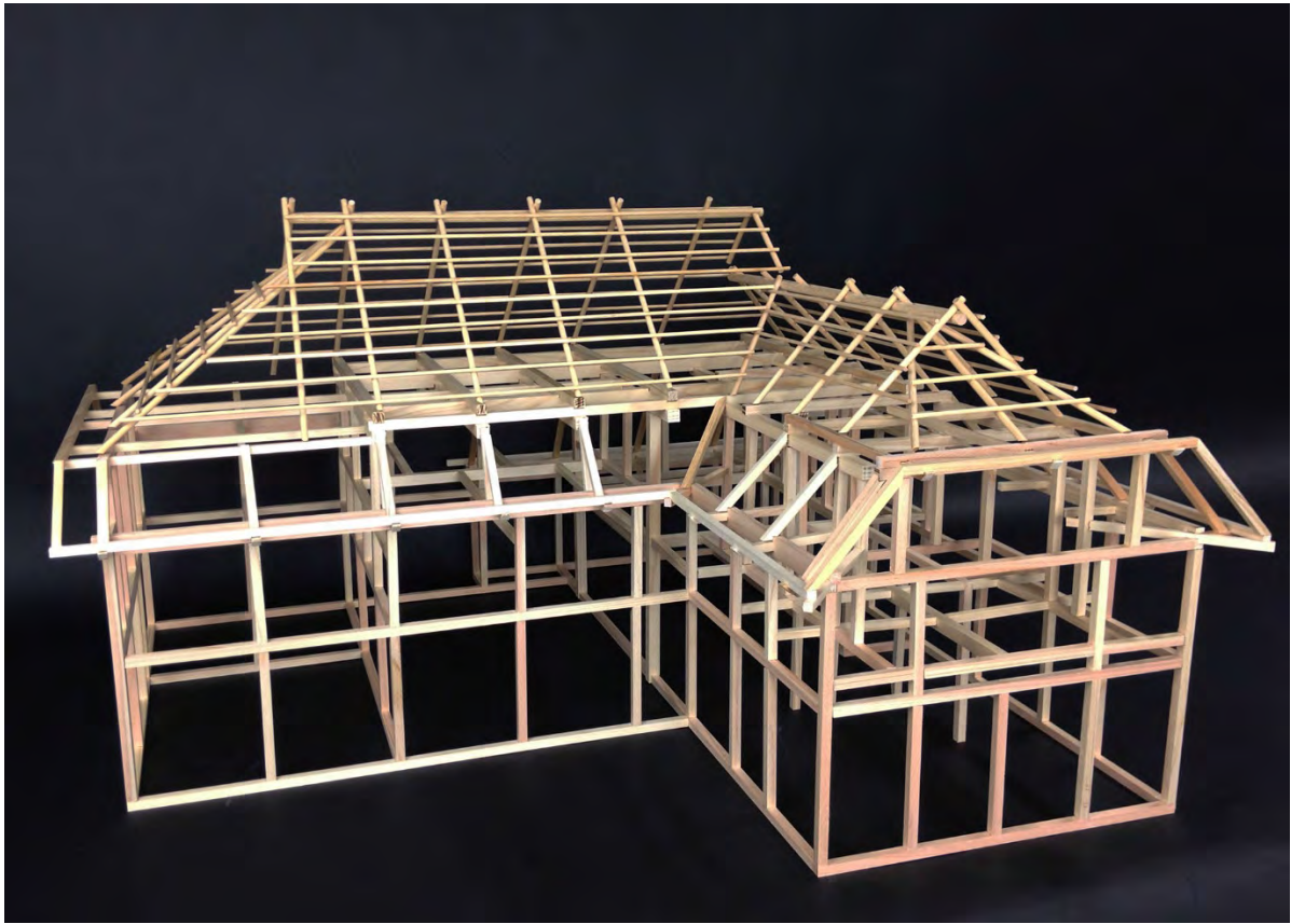
fig. 33 実測をもとに製作した軸組模型 全体
