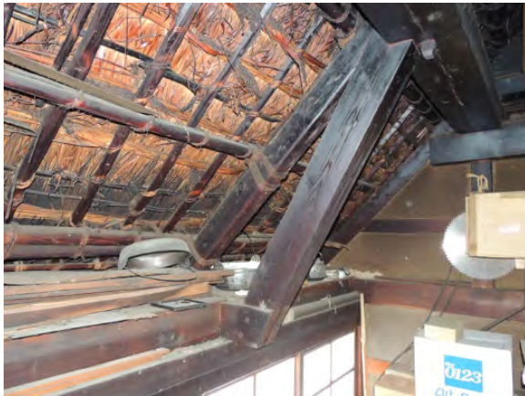
fig. 30 同構法を用いた布沢地区の中門造り民家
