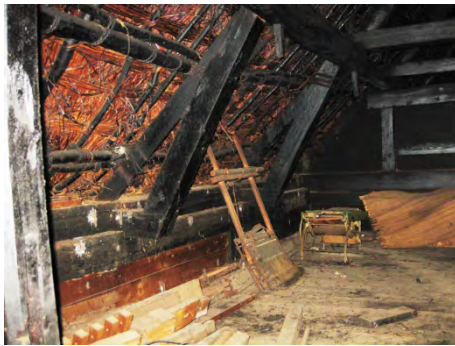
fig. 26 黒谷旧船木家 三角形の軒先構造
