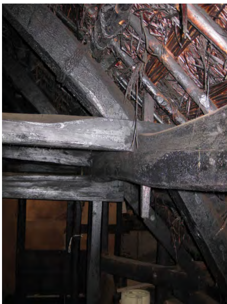
fig. 21 母屋桁と繫梁を木栓で固定している様子
