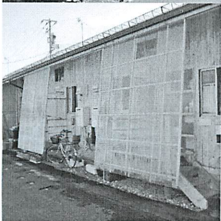
pic. 25 遮光・遮熱パネルを付加した事例
