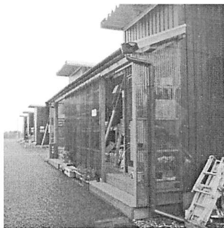
pic. 17 2つの風除室をつないで設置された付加的要素
