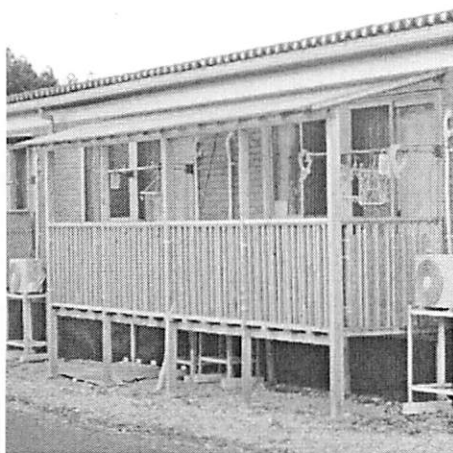
pic. 30 閉鎖性の高いベランダの設置事例 1
