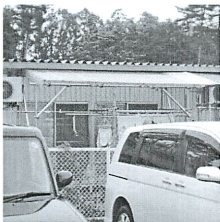
pic. 23 雨のための庇を付加した事例 1
