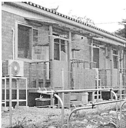
pic. 28 段差を解消するベランダの設置事例
