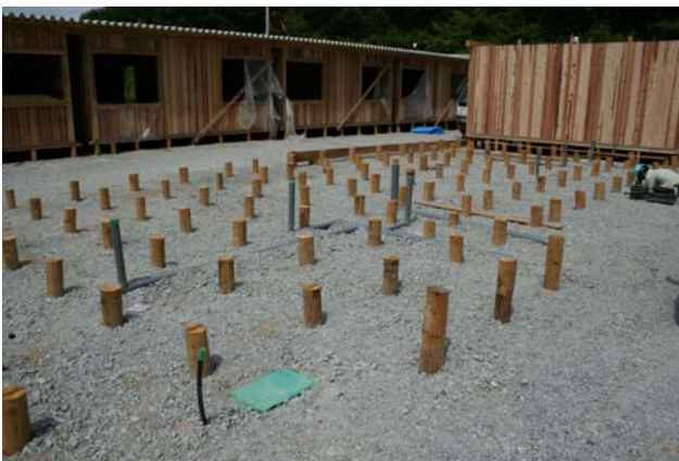
地業後の松杭打設
