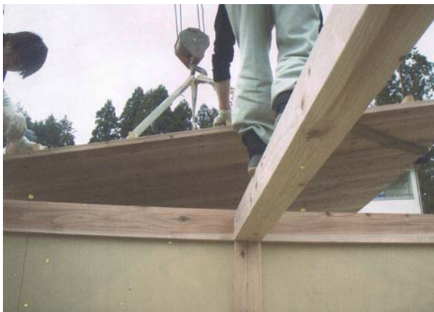
2.7×2.7mのサンドイッチパネルを吊り天井を施工する 杉板による断熱材サンドイッチパネル構法試作風景
