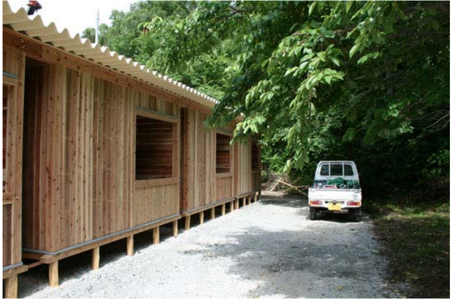
完成直前の木造応急仮設住宅
