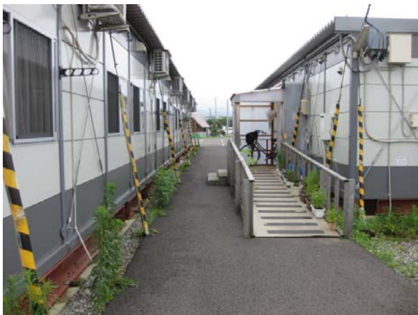
スロープが設置された事例(fig.03)
