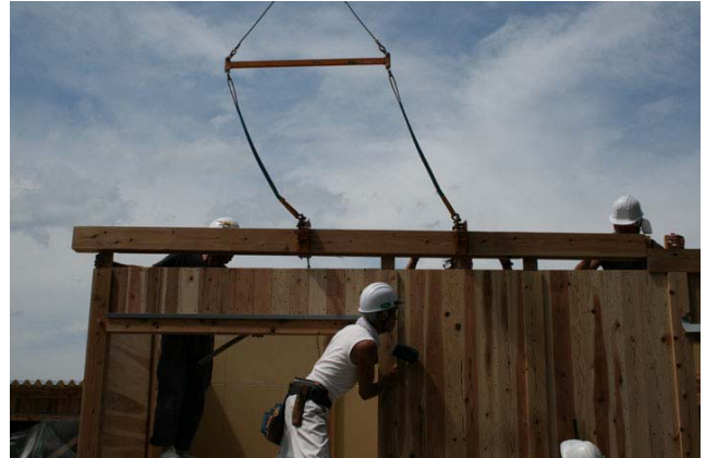
壁パネル吊り込み後の梁取付
