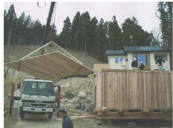
2.7×2.7mのサンドイッチパネルを吊り天井を施工する 杉板による断熱材サンドイッチパネル構法試作風景
