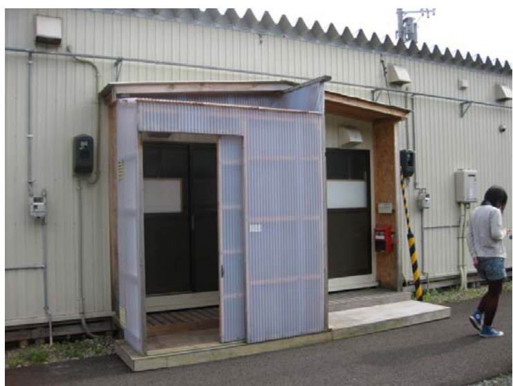
もともと玄関に軒がありこれを利用して後に風除室を取り付けた(fig. 01)
