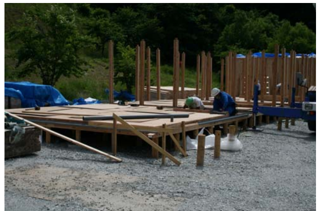
床パネル設置後柱の施工
