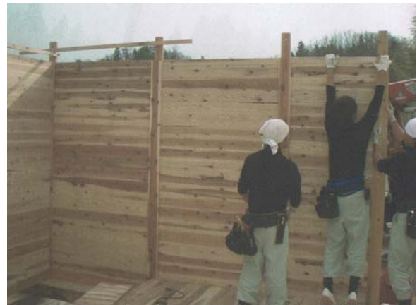
断熱材サンドイッチパネルを柱間に落とし込む
