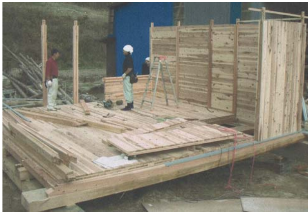
断熱材サンドイッチパネルを柱間に落とし込む
