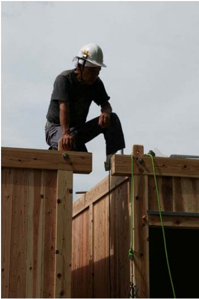
間隙部分の施工
