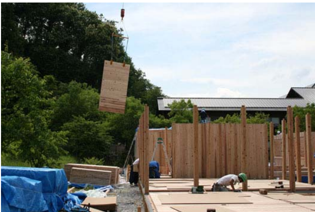
壁パネルの施工
