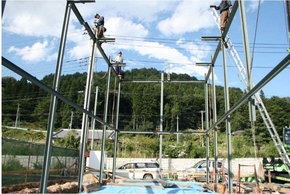
鉄骨の建て方風景：S B工法の採用により仮設足場を組まずに一気に建て方を行う
