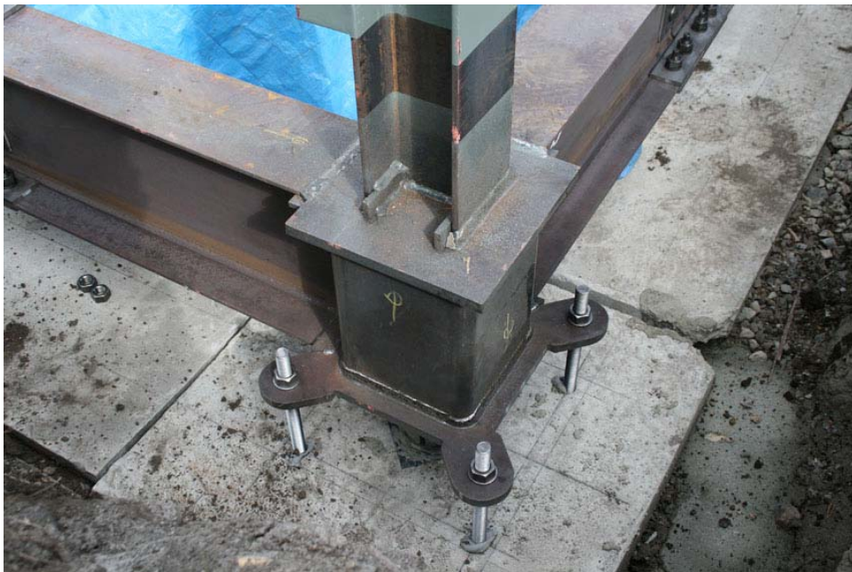
大臣認定工法のSB工法による基礎部分
