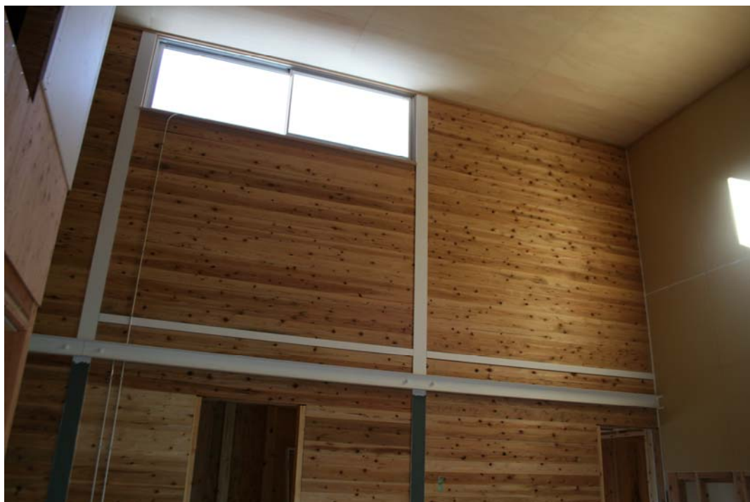
施工中の内観(杉角材は内外装を兼ねている)
