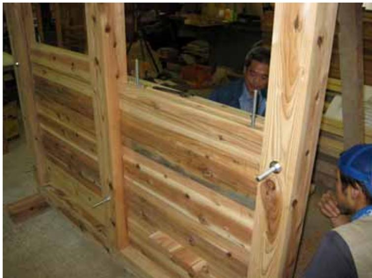
Fig.9-1:杉材積層パネルモックアップ
