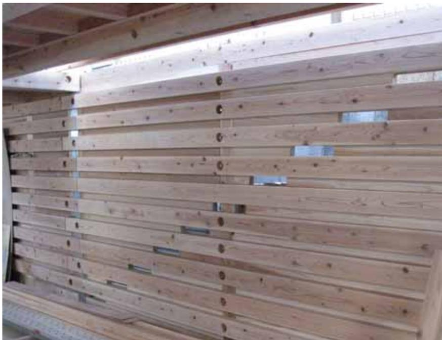
Fig.10: 杉材積層パネル据付風景(開口部は階段取付け部分)
