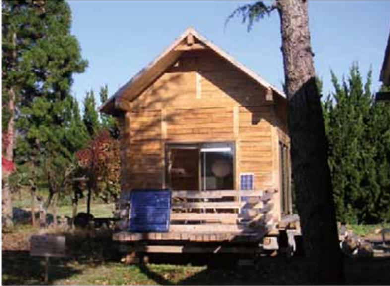
Fig.11: 湿度データ採取を行った校倉造モデル住宅
