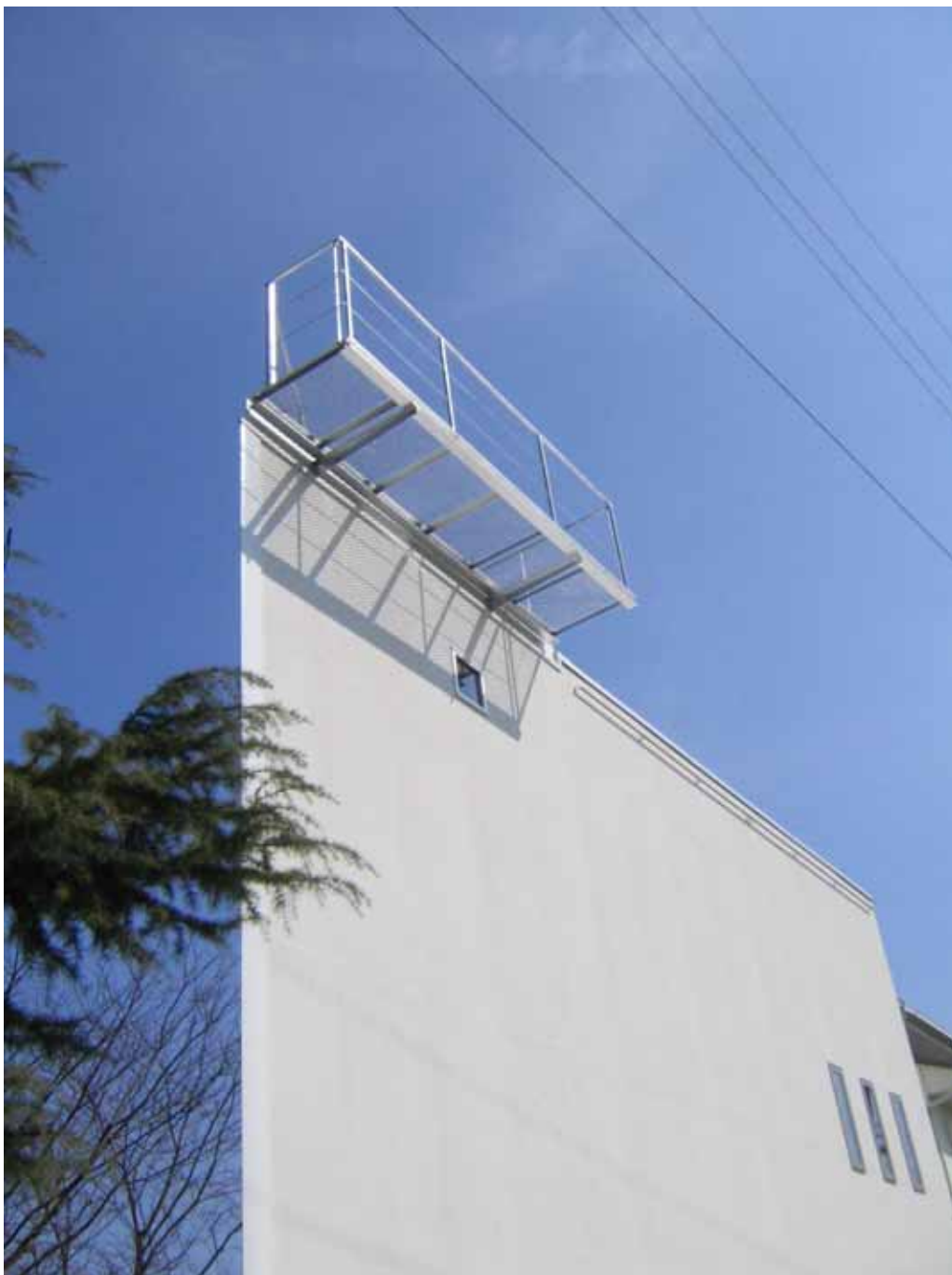
外壁・ベランダ外観
