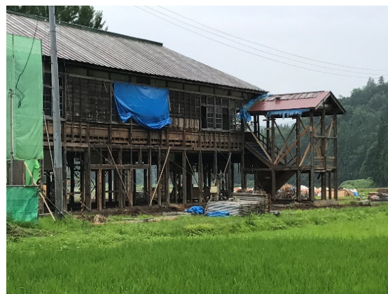
図 2:2017/07/22 撮影 旧喰丸小学校 裏面
